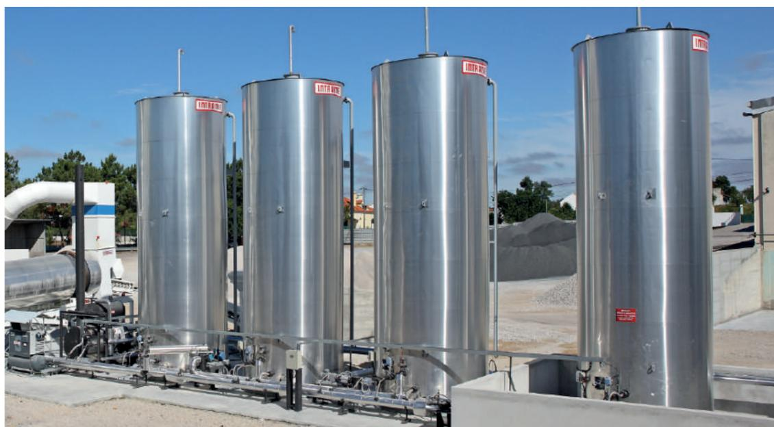
Tanques verticales con calentamiento por aceite térmico.
