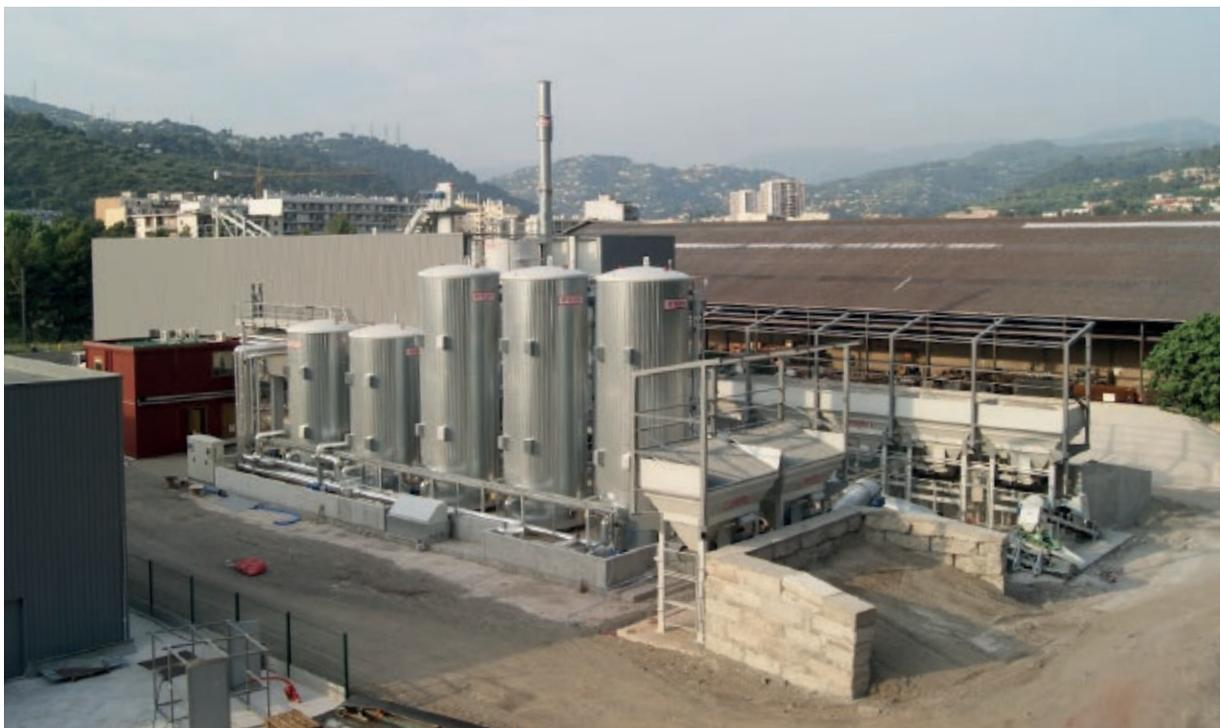
Centrale d'enrobage de 120 t/h avec tour de dosage-malaxage InNOVA-S spéciale (sans crible) enfermée partiellement dans un bâtiment métallique. Équipée de système de recyclage par procès à froid avec décharge dans le malaxeur. Citernes de bitume, émulsion et bitume fluxé avec chauffage électrique. Malaxeur de 1.500 kg. Installée à Nice (France).
