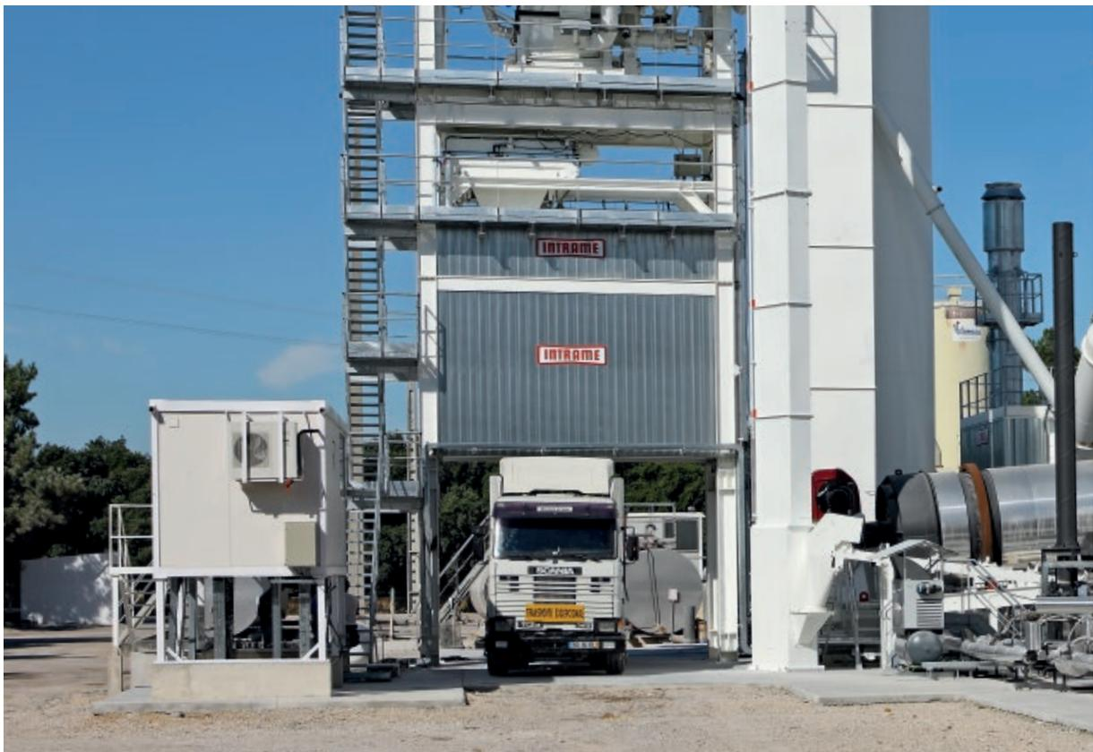
Centrale avec trémie sous le malaxeur. Décharge par gravité sur navette de déplacement horizontal, ce qui permet d'ajouter des trémies supplémentaires.
