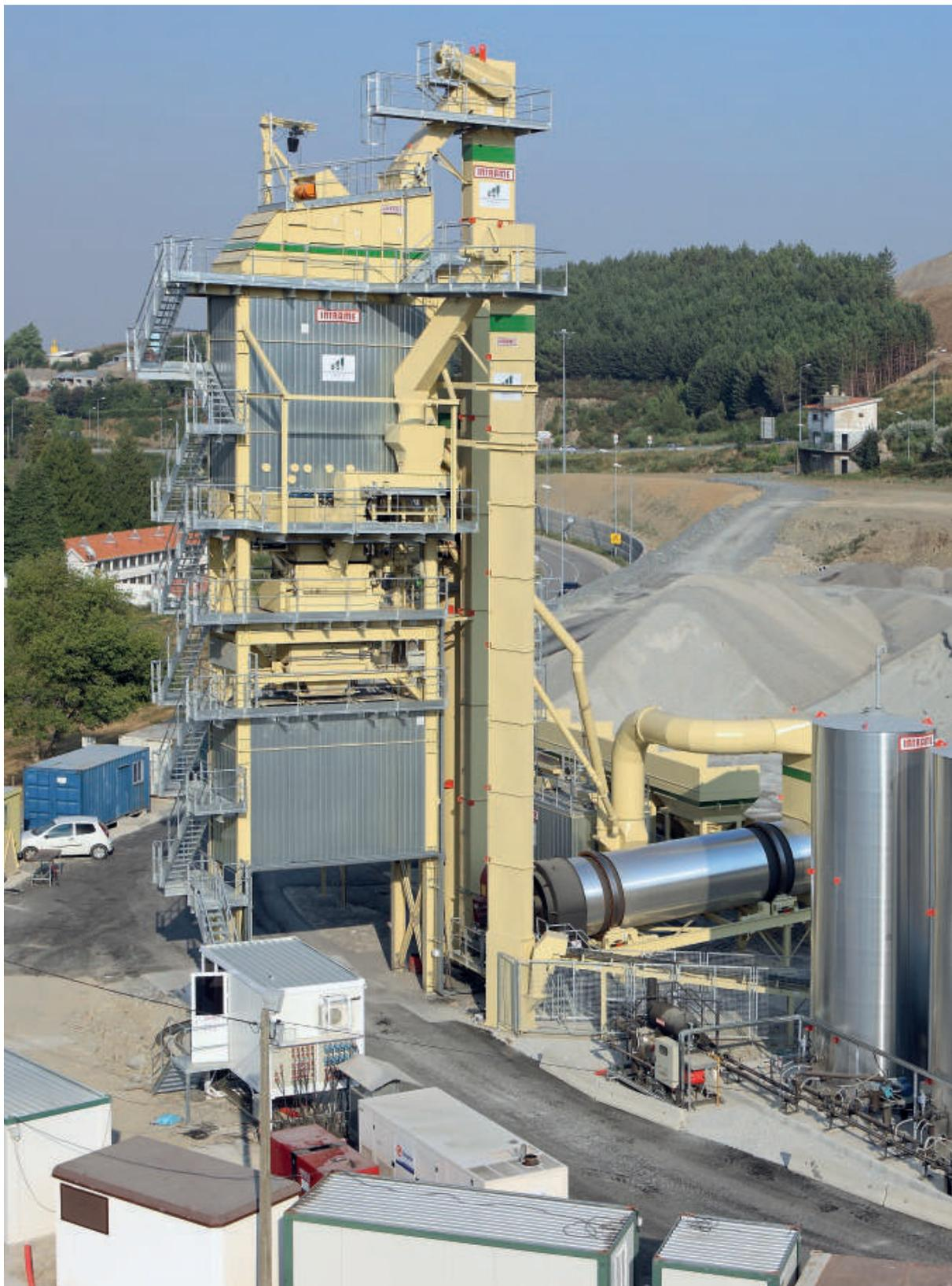
Centrale d'enrobage de 200 t/h (Portugal). Avec tour de dosage-malaxage InNOVA-S. Équipée de trémies de stockage d'agrégats chauds de 90 t et trémie de stockage d'enrobés de 57 t. Malaxeur de 2.500 kg. Équipée de système de recyclage par procès à froid avec décharge dans le malaxeur.
