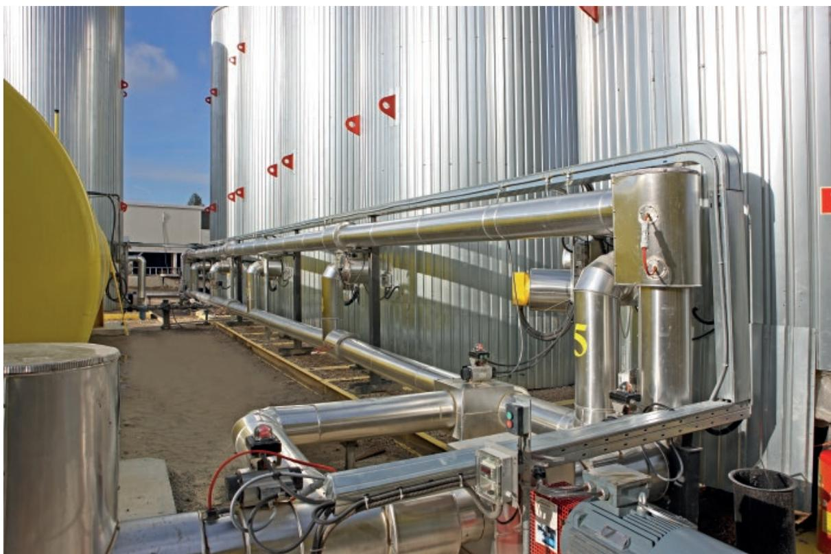
Tuyauteries avec chauffage électrique en centrale InNOVA 320 (Pologne).
