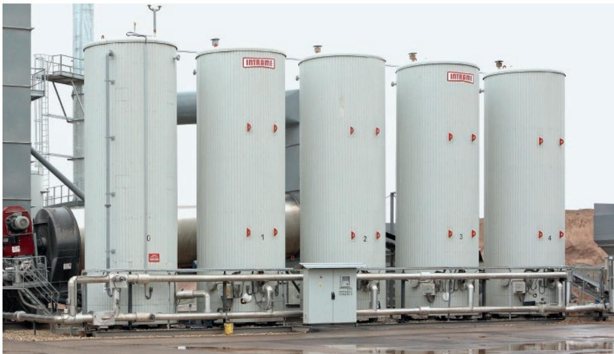
Parc à liants avec chauffage électrique en centrale InNOVA 320 (Pologne).
