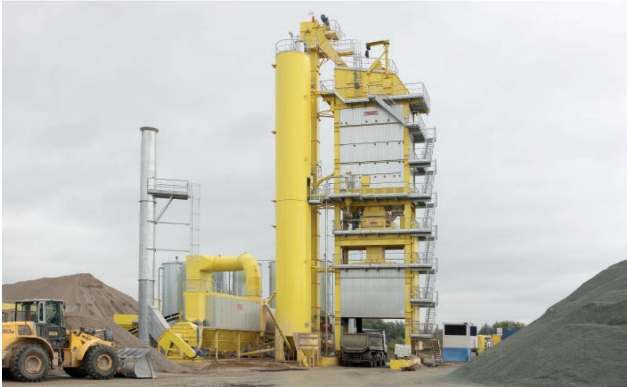
Centrale d'enrobage de 320 t/h (Pologne). Avec tour de dosage-malaxage InNOVA-G. Équipée de trémies d'agrégats chauds de 160 t et trémie de stockage d'enrobés de 81 t. Malaxeur de 4.500 kg.
