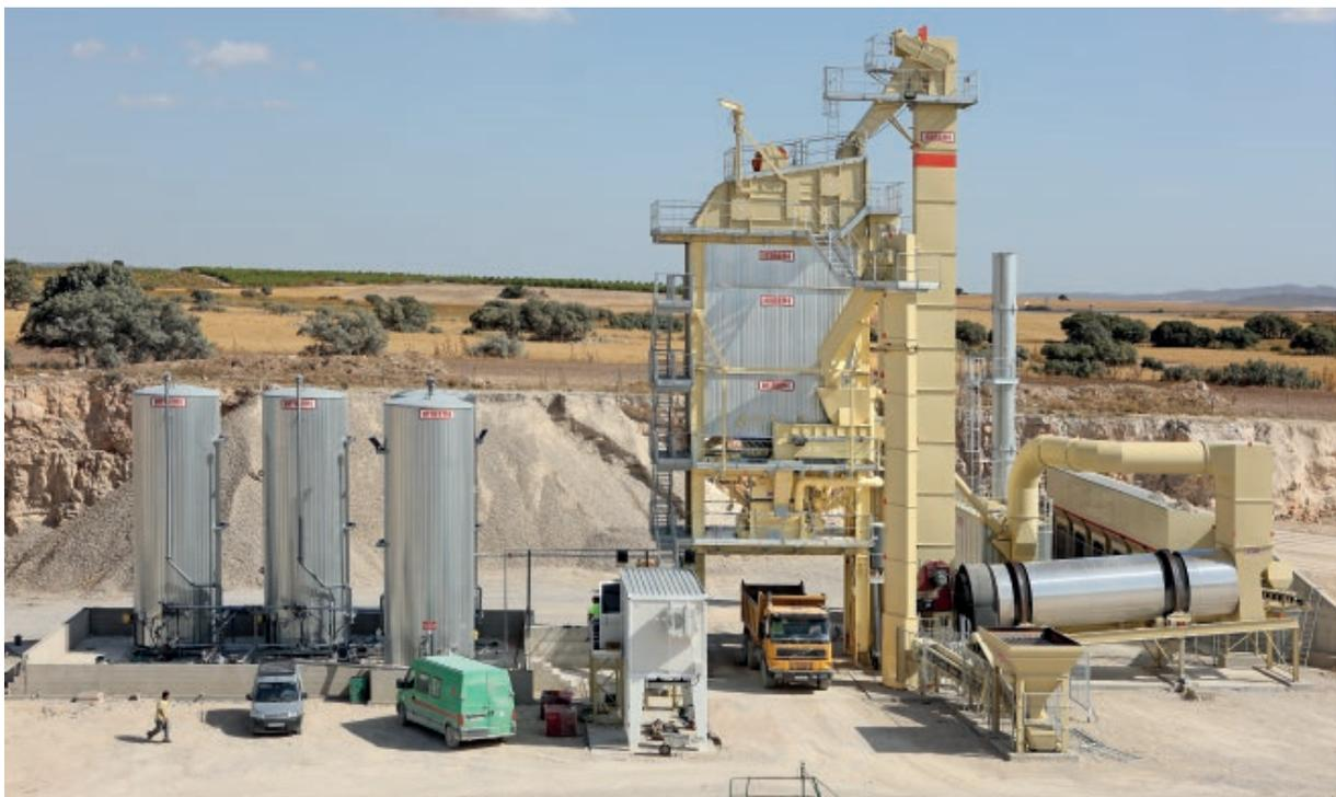
Centrale d'enrobage de 280 t/h (Espagne). Avec tour de dosage-malaxage InNOVA-G. Équipée de trémies d'agrégats chauds de 160 t. Citernes de bitume et fuel avec chauffage électrique. Malaxeur de 4.500 kg. Équipée de système de recyclage par procès à froid avec décharge dans le malaxeur.
