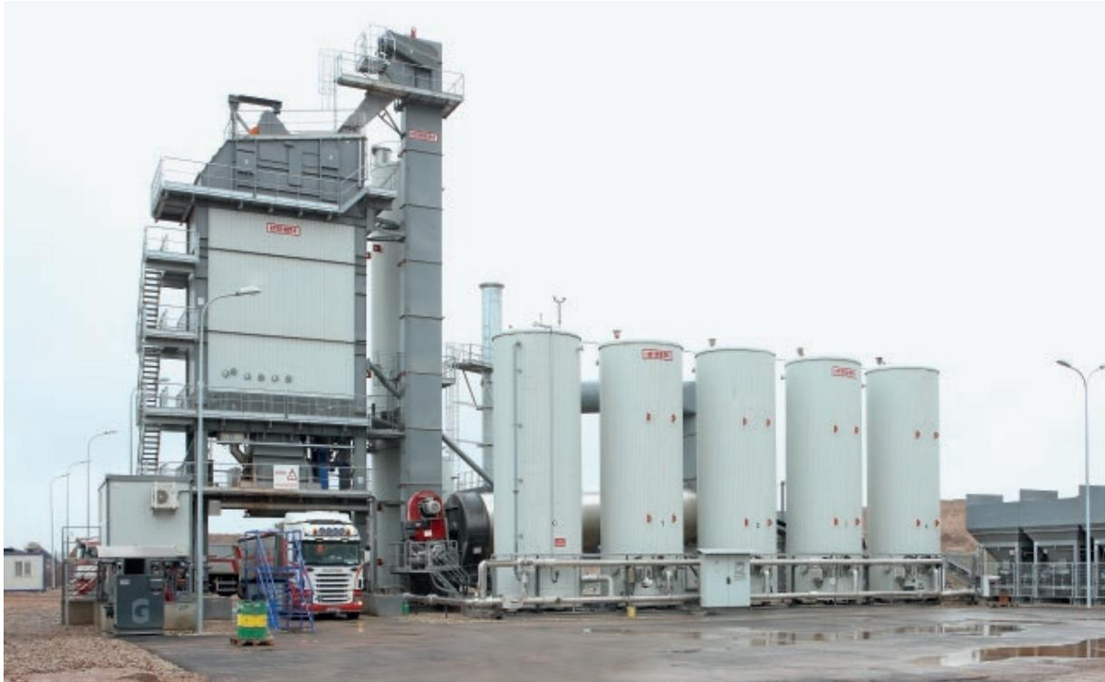
Centrale d'enrobage de 320 t/h (Pologne). Avec tour de dosage-malaxage InNOVA-G équipée de trémies d'agrégats chauds de 160 t. Citernes de bitume avec chauffage électrique. Installée sur fondations métalliques. Malaxeur de 4.500 kg.
