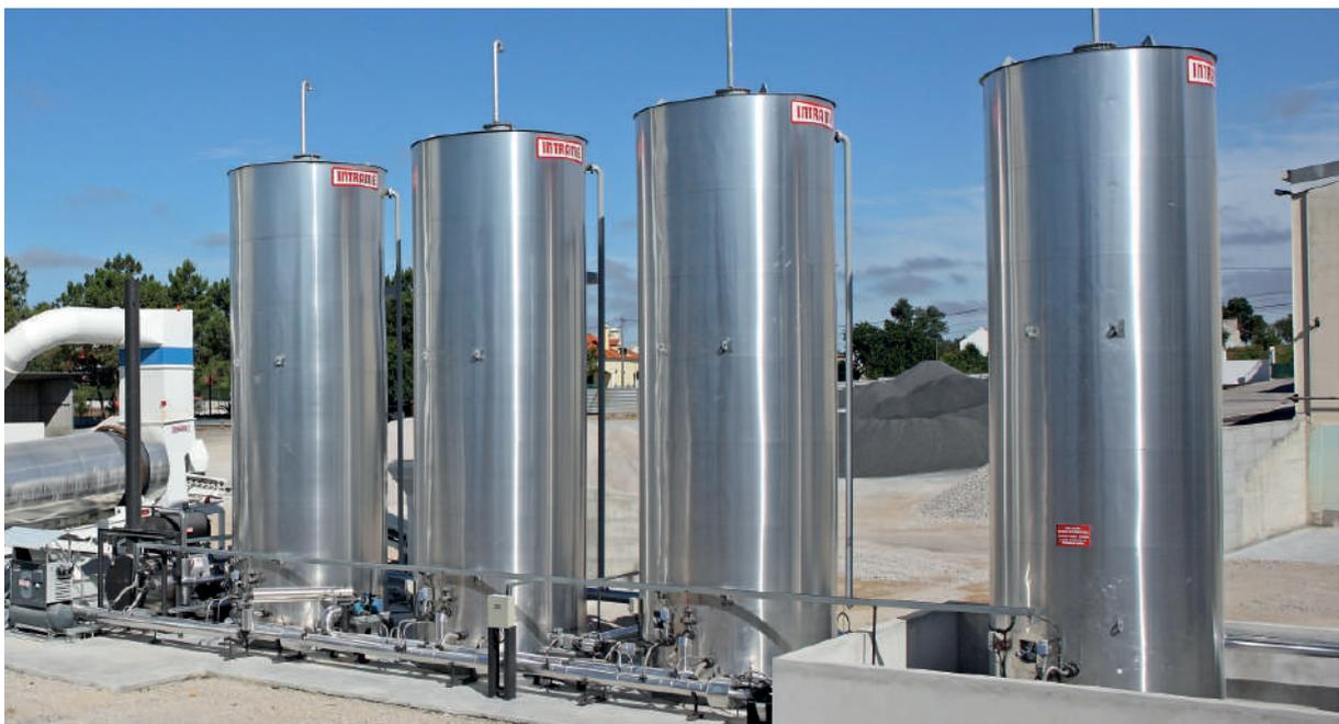
Tanques verticales con calentamiento por aceite térmico.
