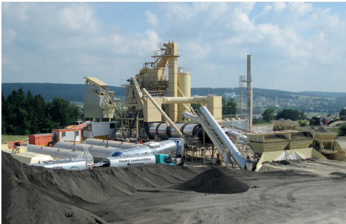
Equipo de reciclado en caliente RC-120 instalado en planta M-280 (Suiza).
